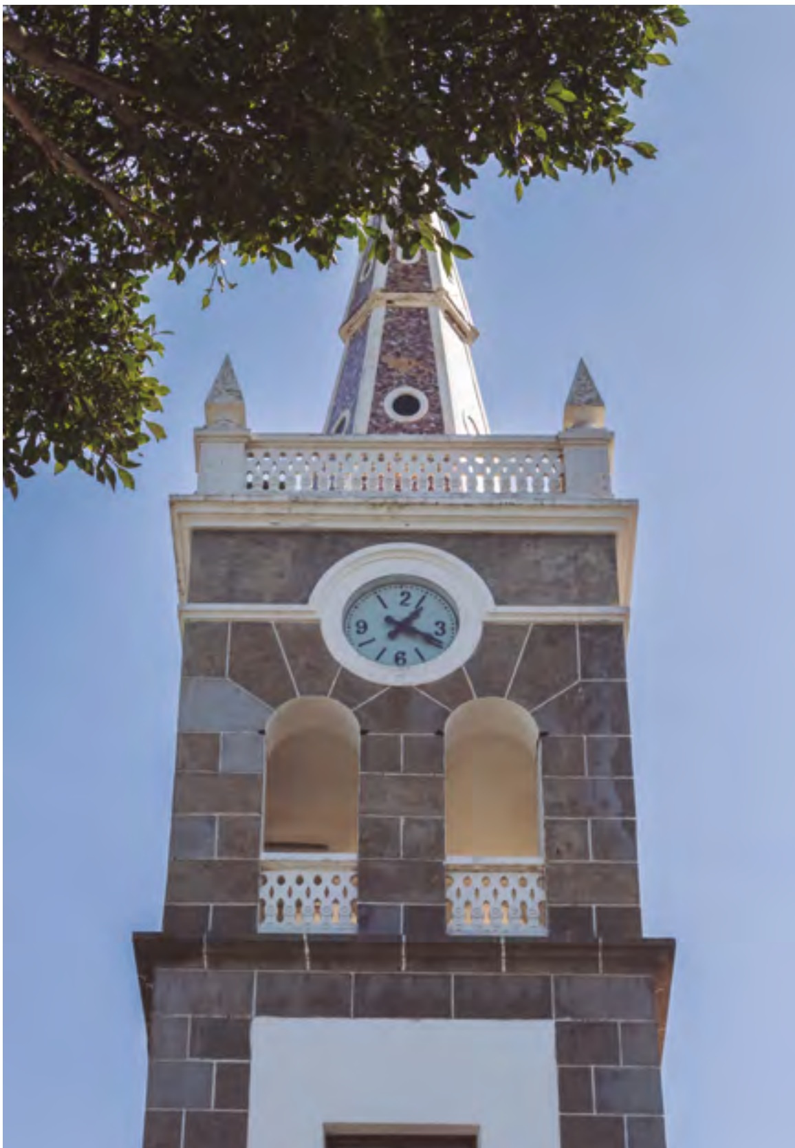
Detalle de la torre campanario de San Bartolomé de Tejina.
